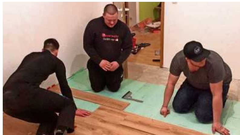
Der Fußboden wird in der neuen Wache verlegt ...
