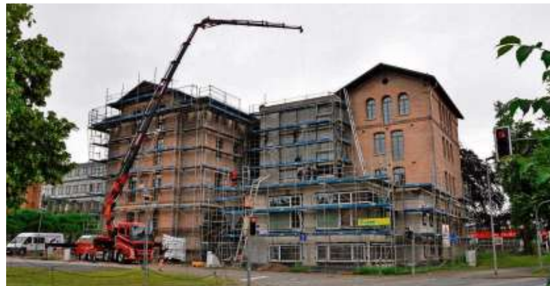
Der Fokus der Bauarbeiten war dieser Tage auf dem modernen Fahrstuhlschacht.
