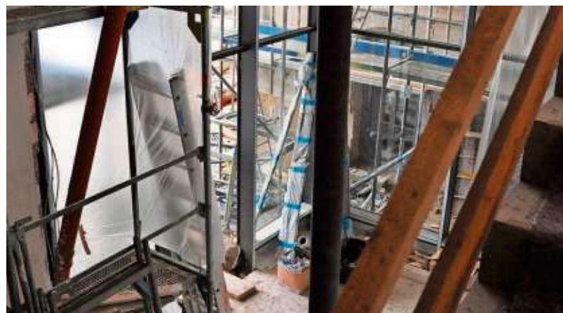
Im Treppenhaus nach unten geschaut, in den zukünftigen Eingangsbereich.
