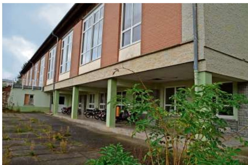
Betonplatten weg, Garten hin: An der Rückseite soll es gemütlich werden.
