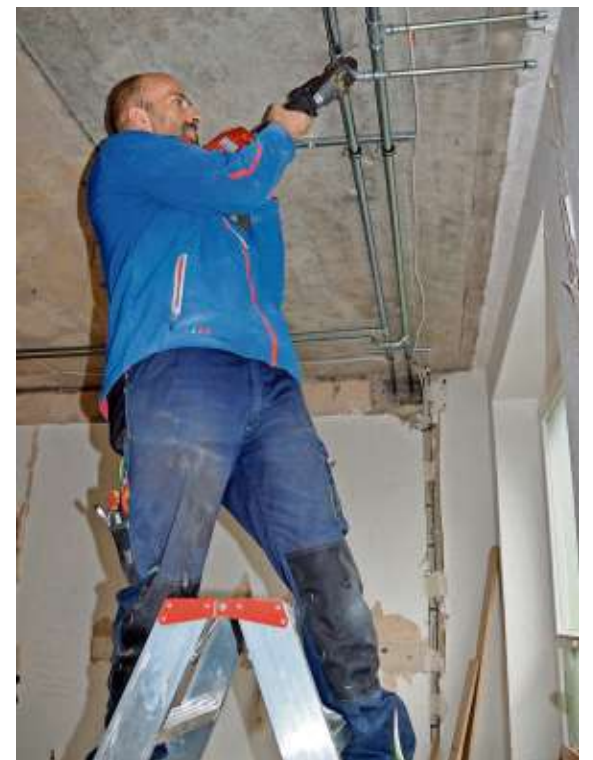
Marcel Bauße vom Heizungs- und Sanitärbau Kellner und Luther aus Obermaßfeld ist nur einer der vielen heimischen Handwerker, die hier bauen. Auch die Firma Engelman, Oberweid, Trockenbau Tews, Meiningen, Fliesenleger Ullrich, Walldorf, und die Firma Richter aus Kaltensundheim (Abbruch) sind oder waren hier auf der Baustelle tätig. Fotos: Iris Friedrich
