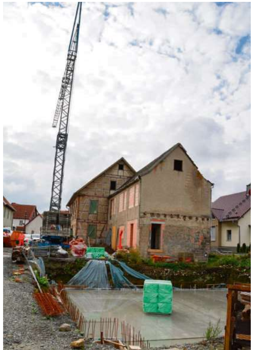
Rückseitig bekommt das Haus einen Anbau. Altes wurde hierfür abgerissen.
