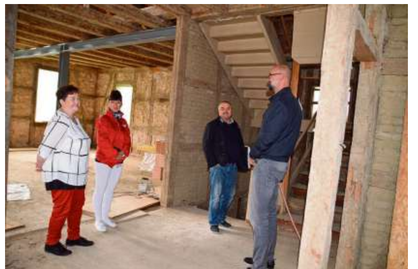
Mitten auf der Baustelle: Antje Frieß und Ivonne Dittmar vom DRK-Pflegedienst mit Klaus Zander und Matthias Schneider, Vorstand des DRK Meiningen.
